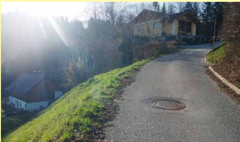
Sieht so eine ausreichende Zufahrt für 14 neue Bauparzellen aus?
